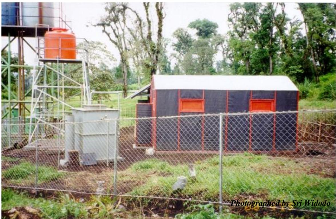
Gambar 3. Pilot Proyek Percobaan Pemanfaatan Panas Bumi untuk Budi Daya Jamur
