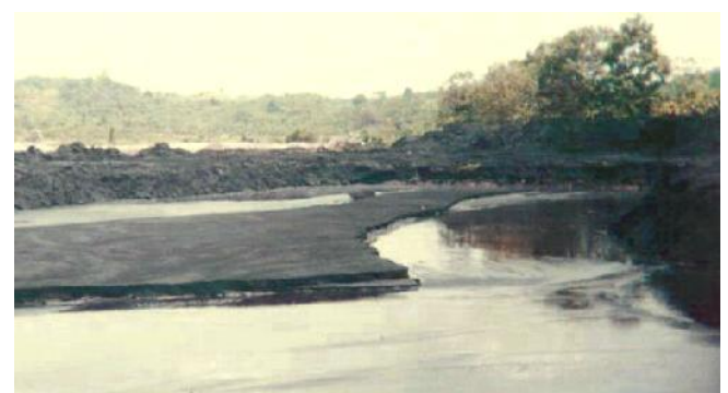
Gambar 2. Settling pond untuk pengendapan fine coal dan lumpur ampas pencucian batubara (Tain dkk., 2001)
