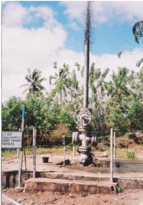
Gambar 4. Instalasi Sumur Eksplorasi AT-1 Lapangan Panas Bumi Atadei, Lembata, NTT
