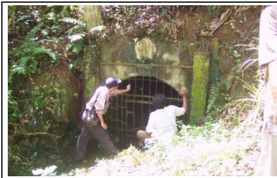
Foto 1. Bekas Terowongan Level Tengah di Salido, Tambang
