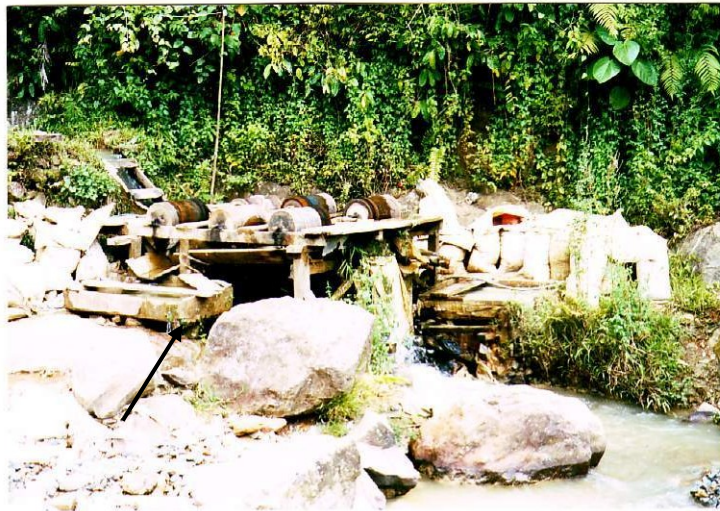
Foto 2 Contoh Unit Pengolahan Bahan Galian Emas, dimana tailing dibuang langsung ke badan sungai (Tanda panah = Bak penampung tailing)
