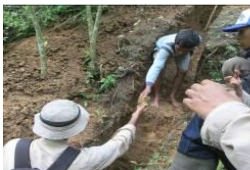
Foto 3. Pekerjaan puritan atau "trenching", di daerah Taruang-Taruang, Rao, Pasaman.
